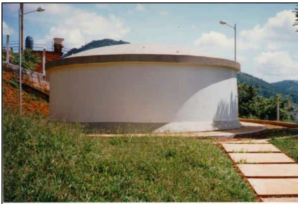
Foto 5 - Reservatório em Concreto Armado Apoiado
