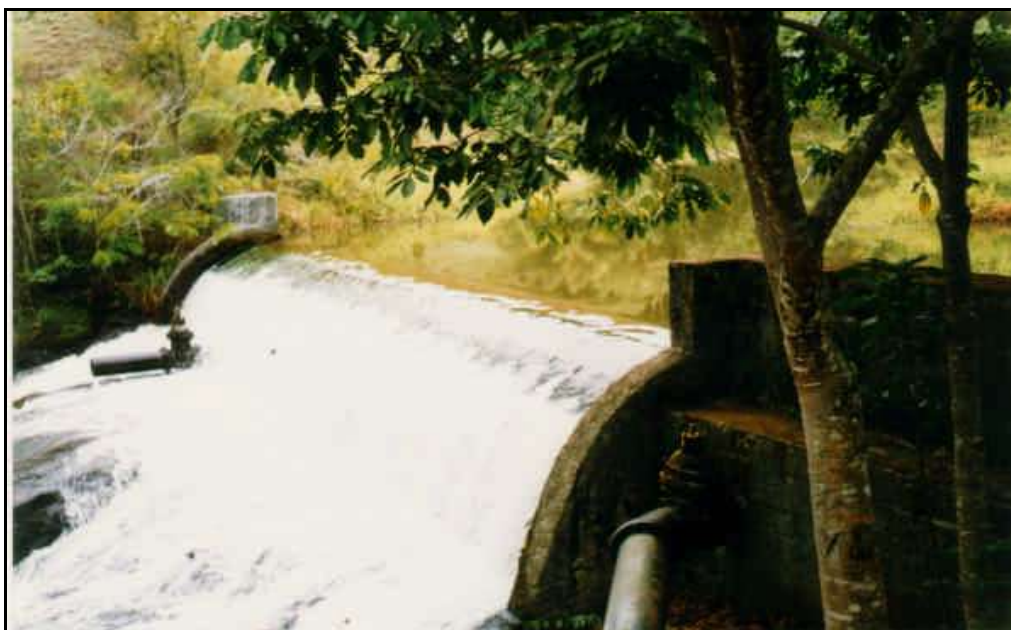
Foto 1 - Tomada Direta com Barragem de Nível
